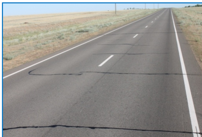
Рисунок 1 – Низкотемпературное растрескивание асфальтобетонного покрытия автомобильной дороги
